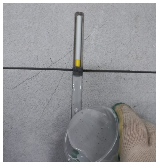
4. Заливка дюбеля смолой Эпорип (Еporip)
