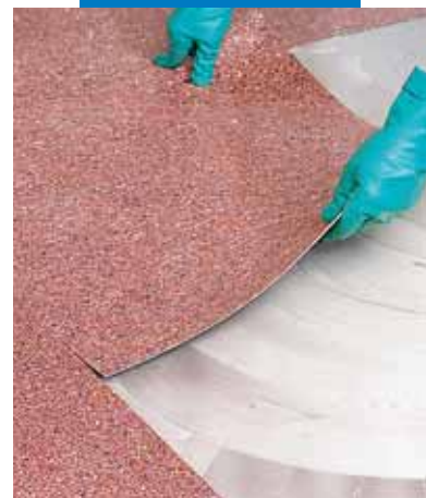
Укладка ПВХ покрытий на клей Adesilex G19
