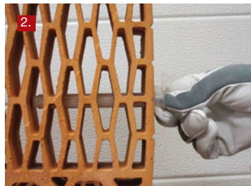
2. Установить в просверленное отверстие соответствующую сетчатую гильзу.
