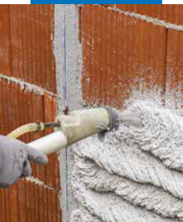
Нанесение Intomar 535 с помощью штукатурной станции
