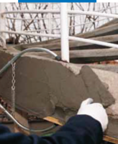
Нанесение Марегрут 230 при помощи мастерка
