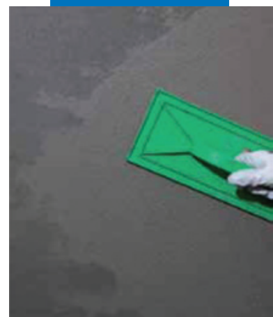
Трамбовка Mapegrout 230
