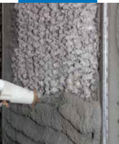
Нанесение Марегрут 230 набрызгом
