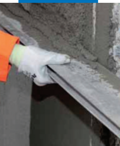
Выравнивание Марегрут 230 при помощи правила
