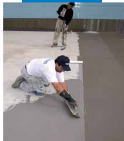
Гидроизоляция бассейна с применением Mapelastic
